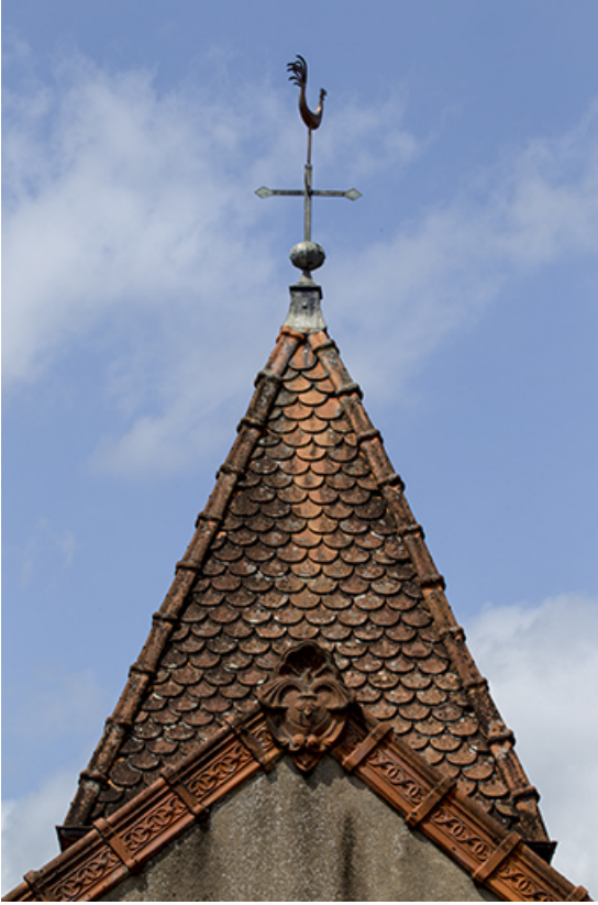
Campanile avec son toit en pavillon.
