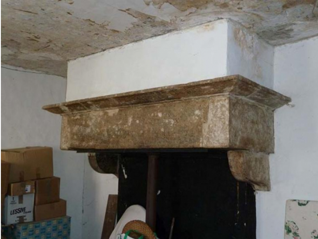
Cheminée de l'étage
