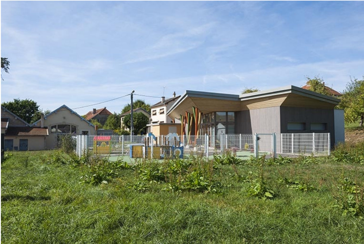
Vue d'ensemble de la crèche.
