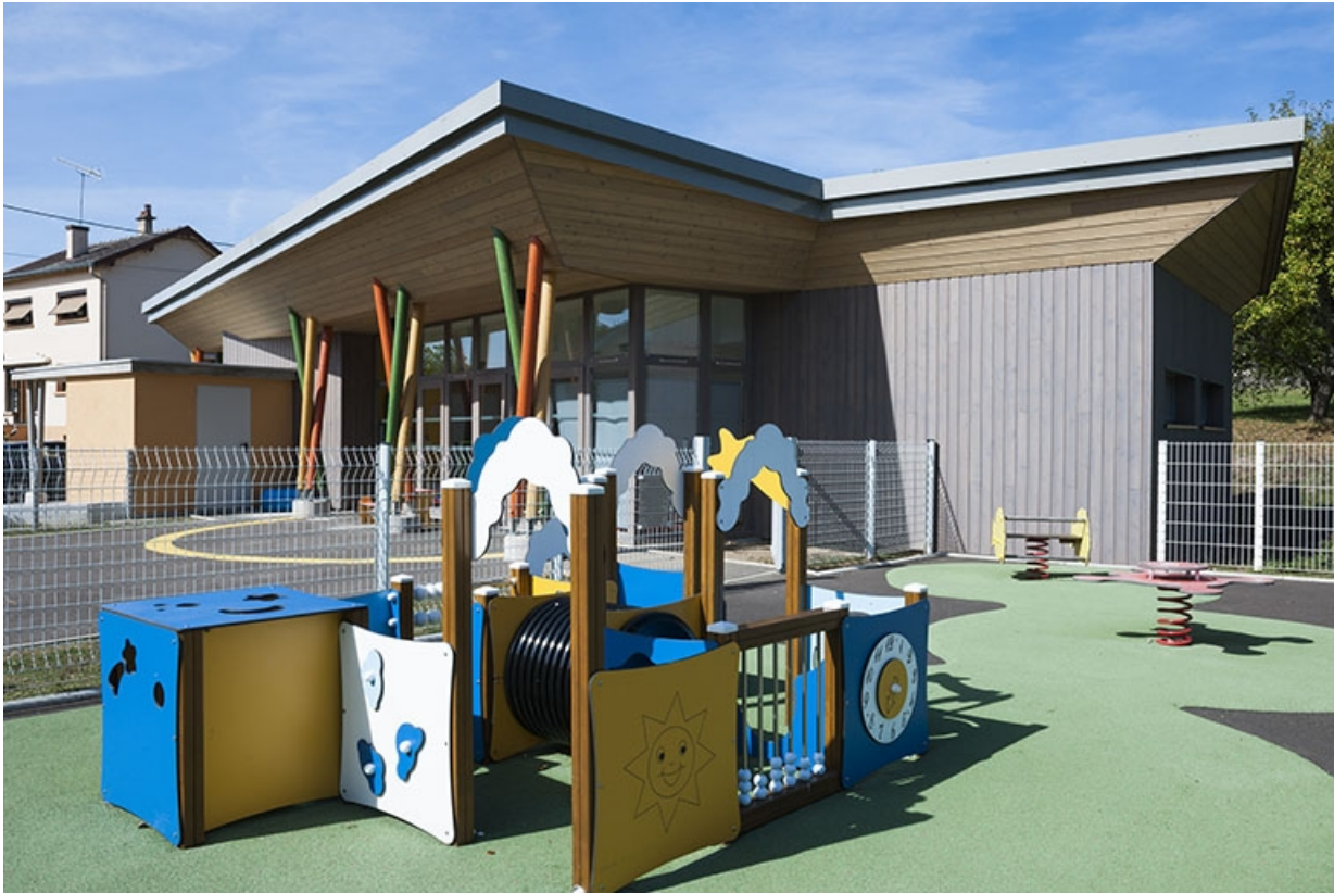
Vue générale de la crèche.
