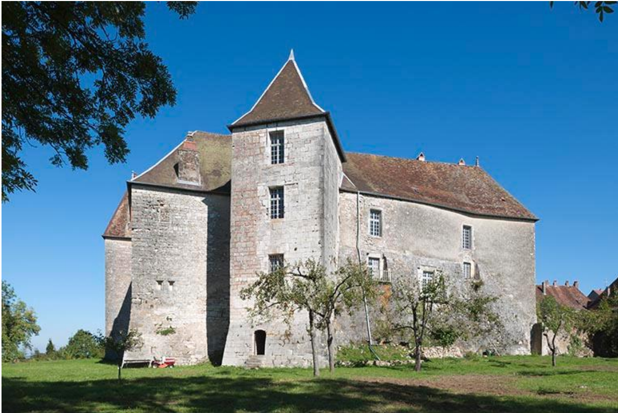
Vue générale ouest
