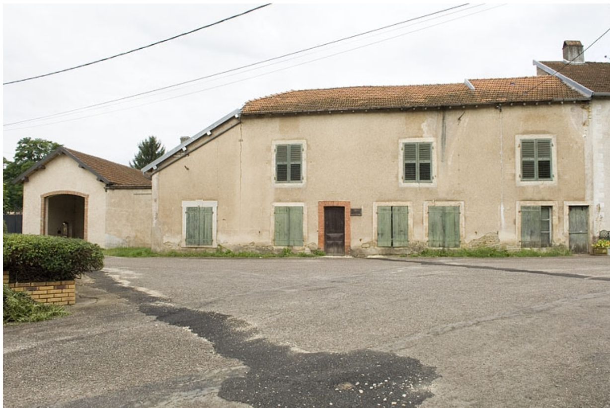
Vue du bâtiment d'entrée.
