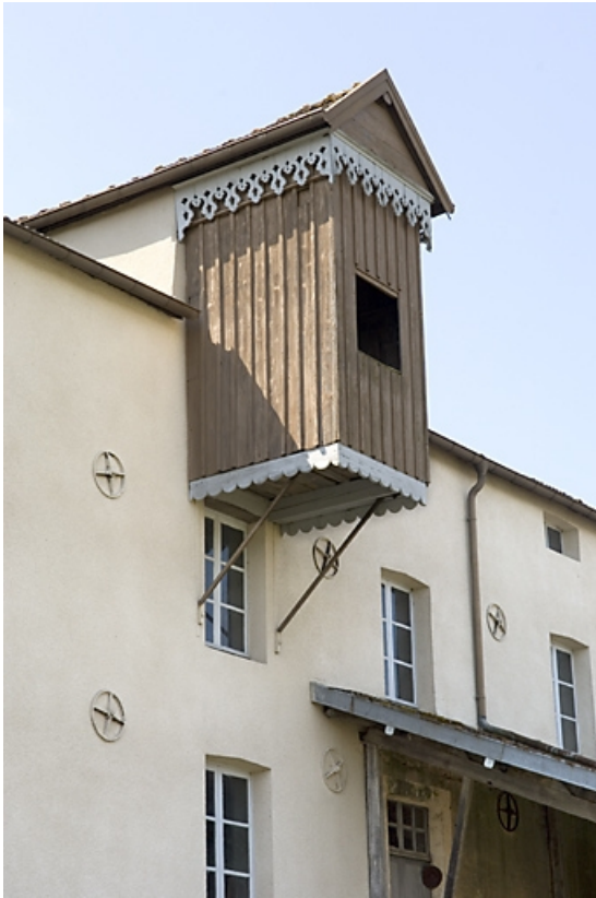
Façade antérieure. Edicule du monte-sac.
