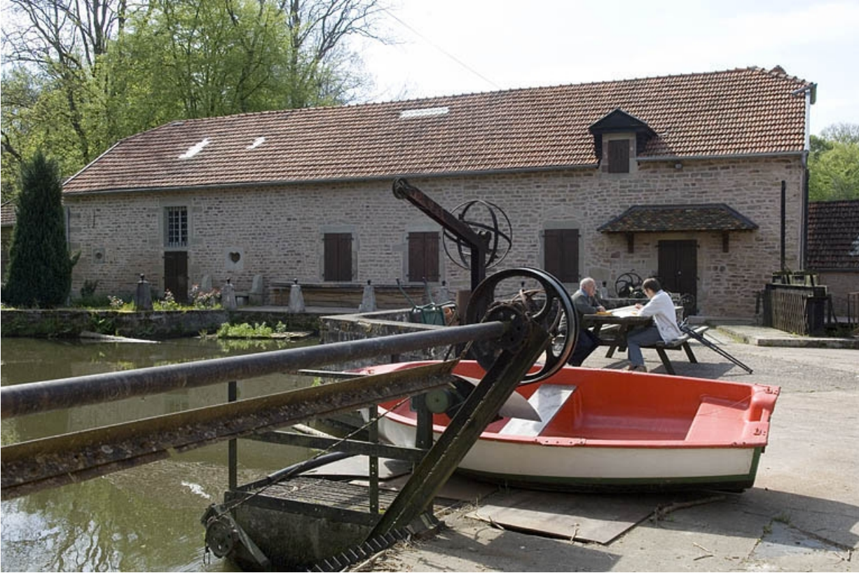
Logement (rive gauche). Façade nord.
