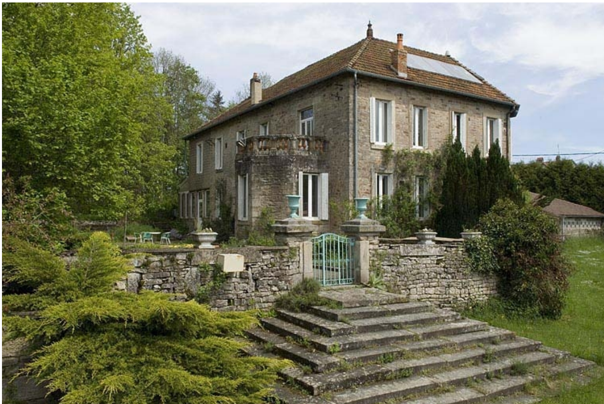
Logement patronal vu de trois quarts.
