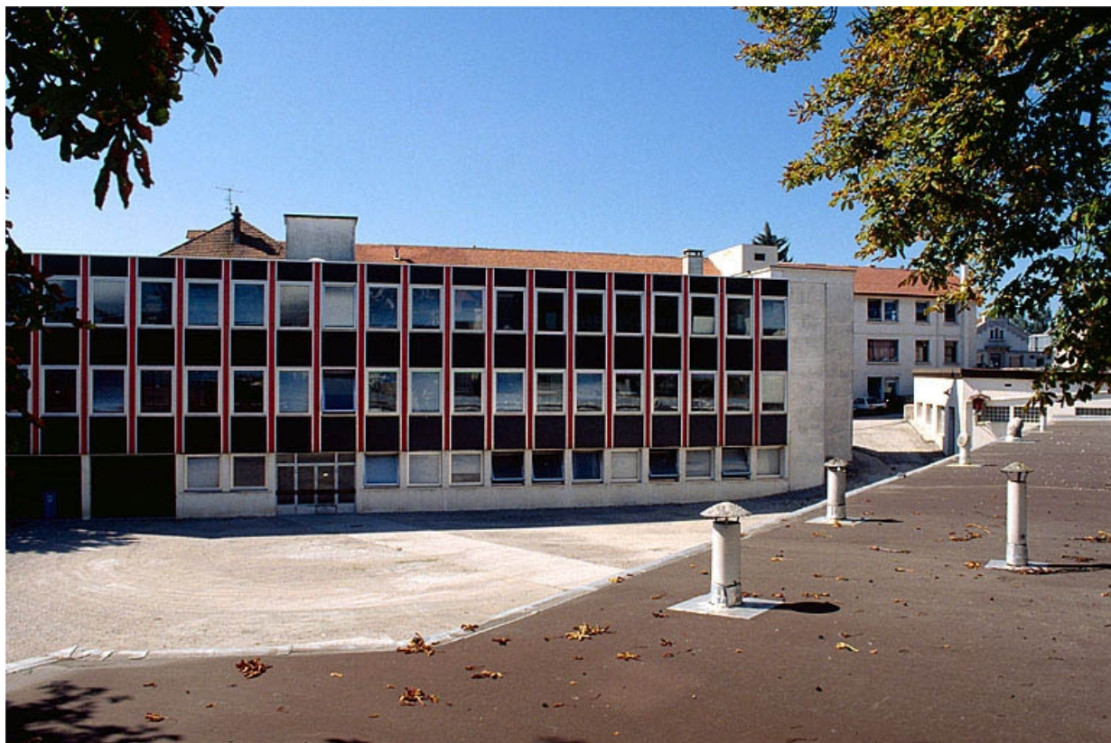
Façade sur cour d'un atelier de fabrication.
