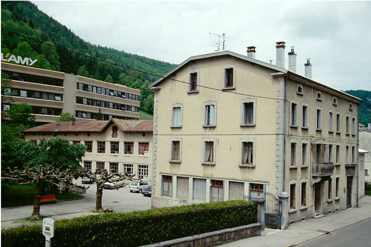
Logement patronal et atelier de fabrication.
