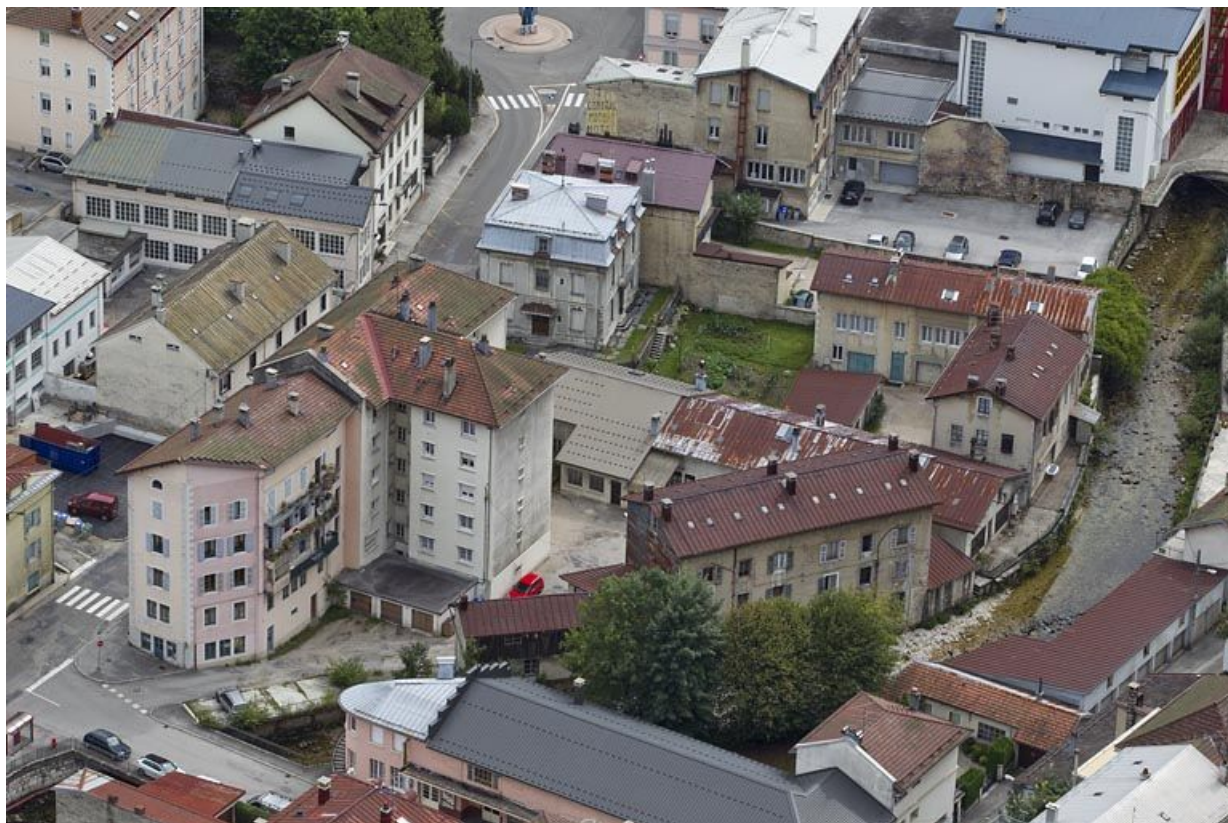
Vue d'ensemble plongeante, depuis le nord.
