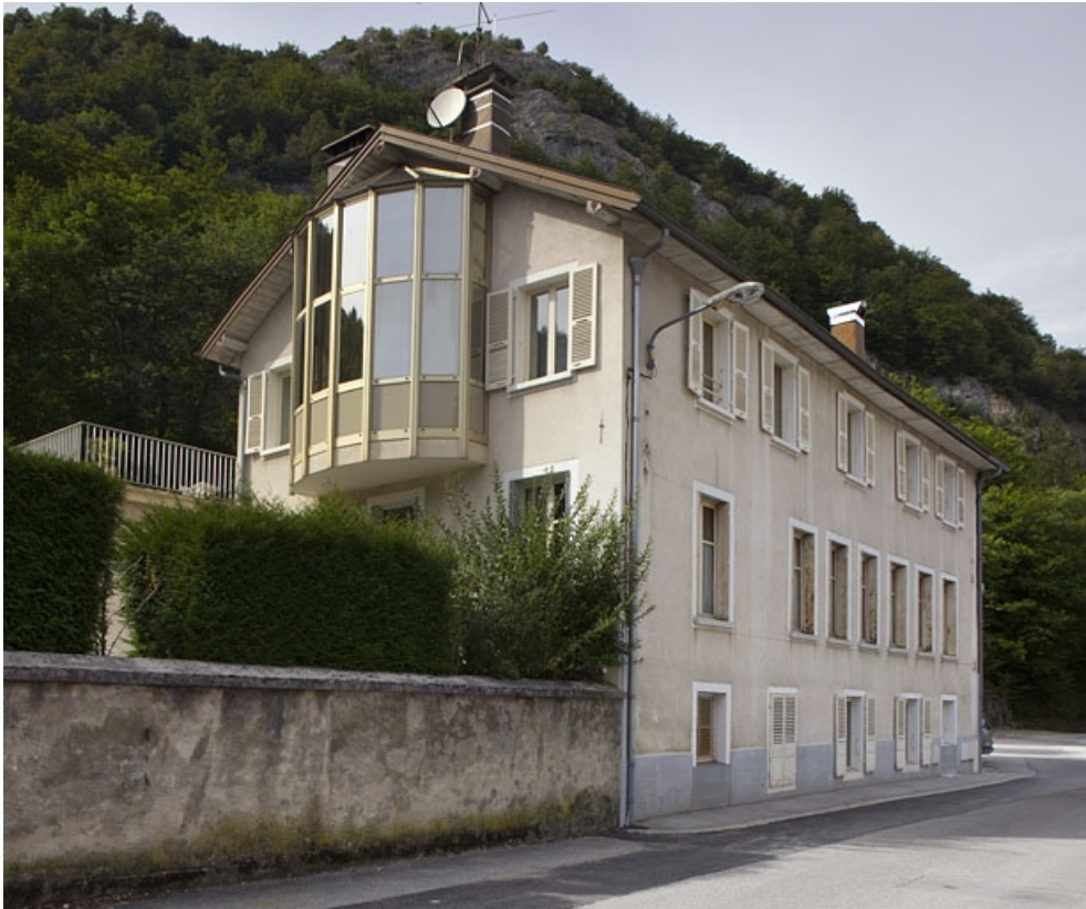
Elévation antérieure, de trois quarts gauche.
