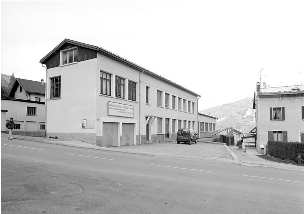
Vue d'ensemble depuis le sud : élévation antérieure.
