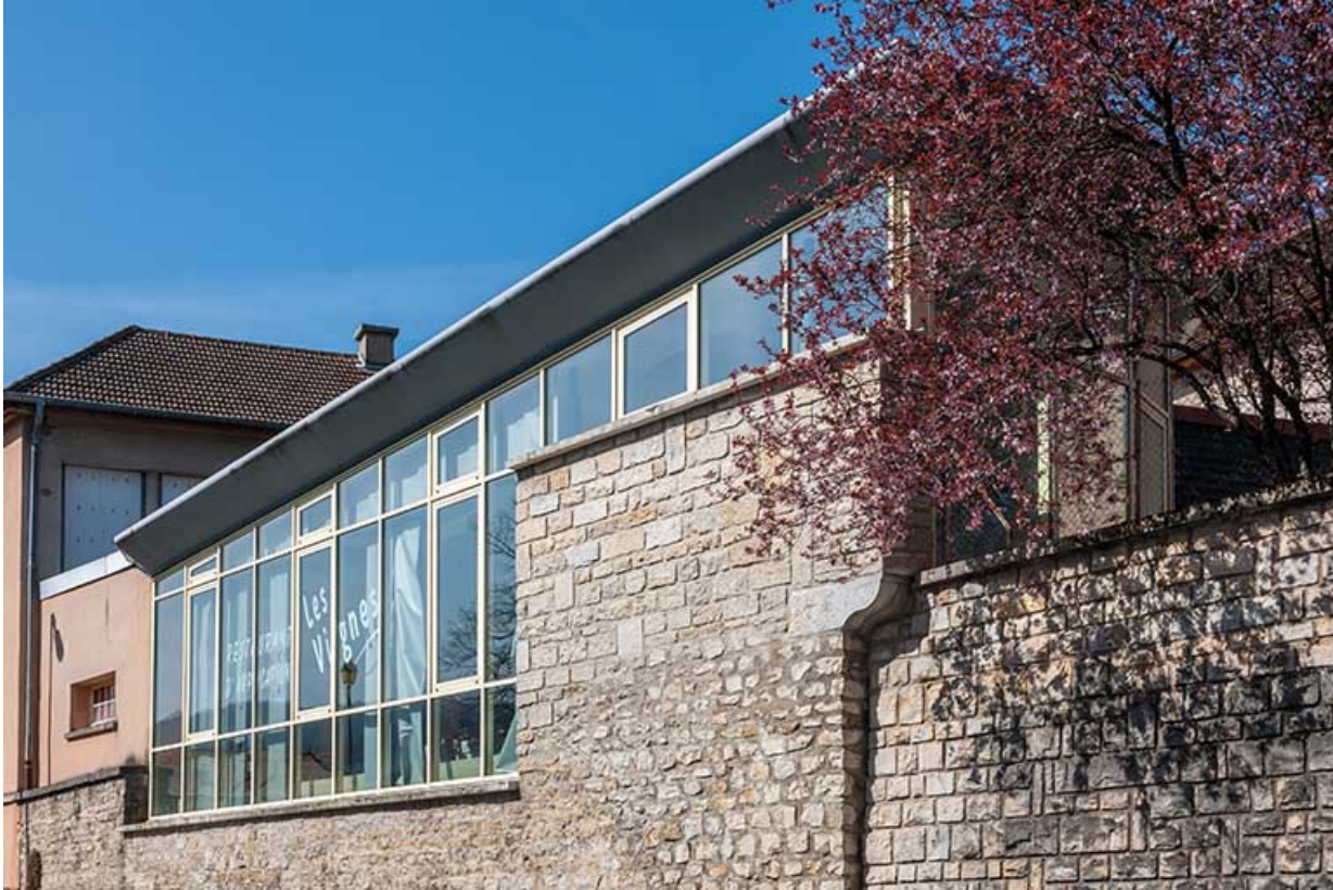
Restaurant d'application : façade sur avenue Delort
