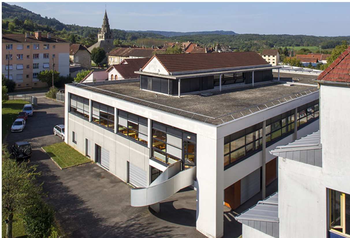
Restauration : façades Nord et latérale Est.
