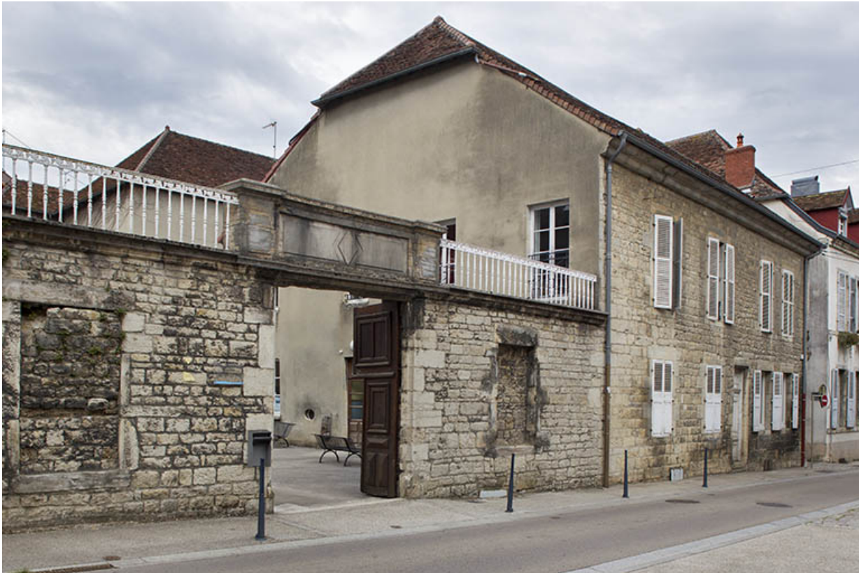
Entrée, rue du collège.
