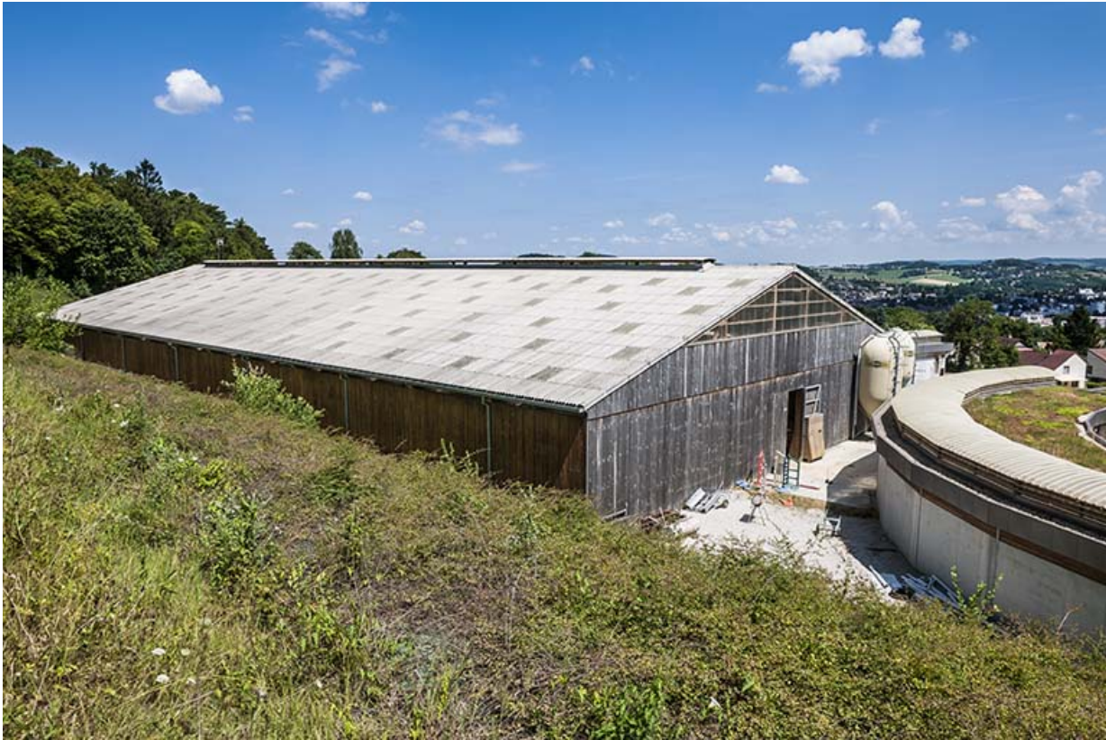
Centre équestre : toiture du manège.
