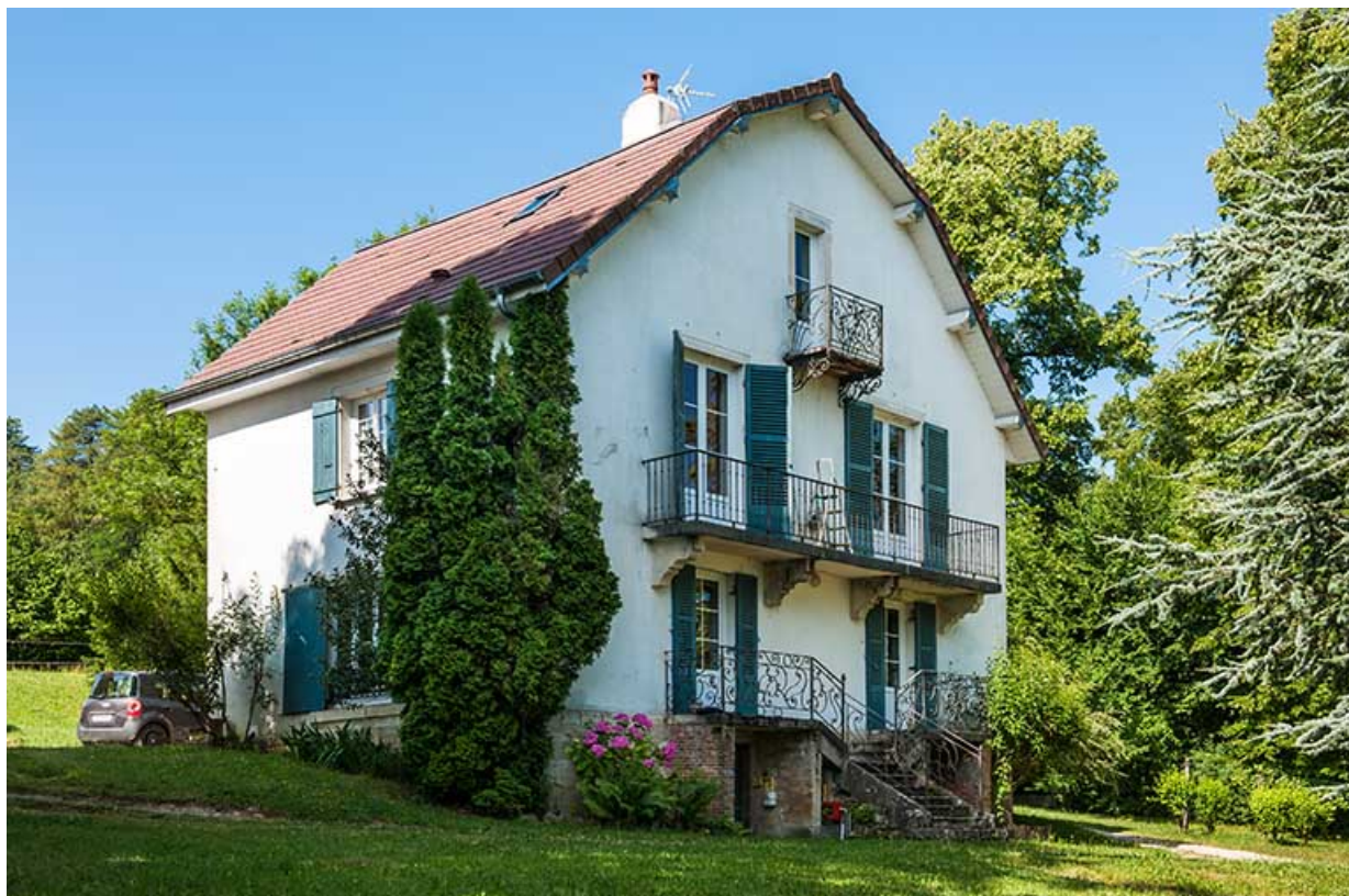
Pavillon du proviseur, vue trois quart.
