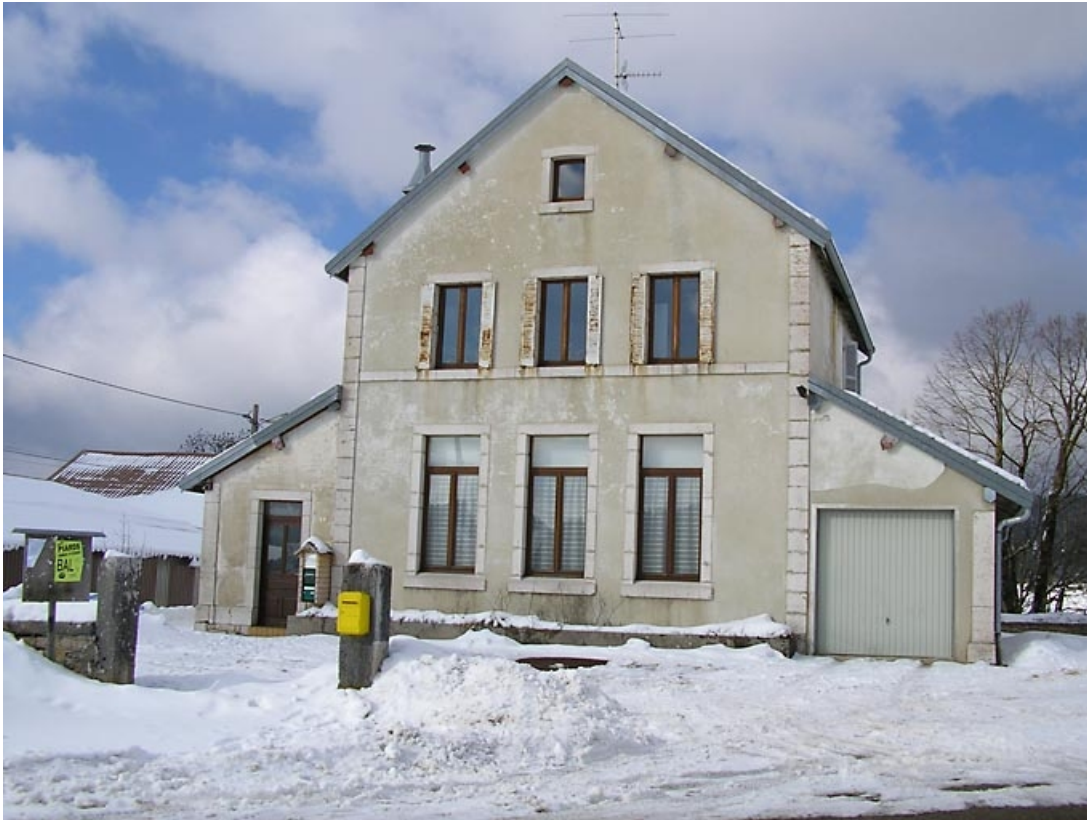
Façade antérieure. 39, Grande-Rivière
