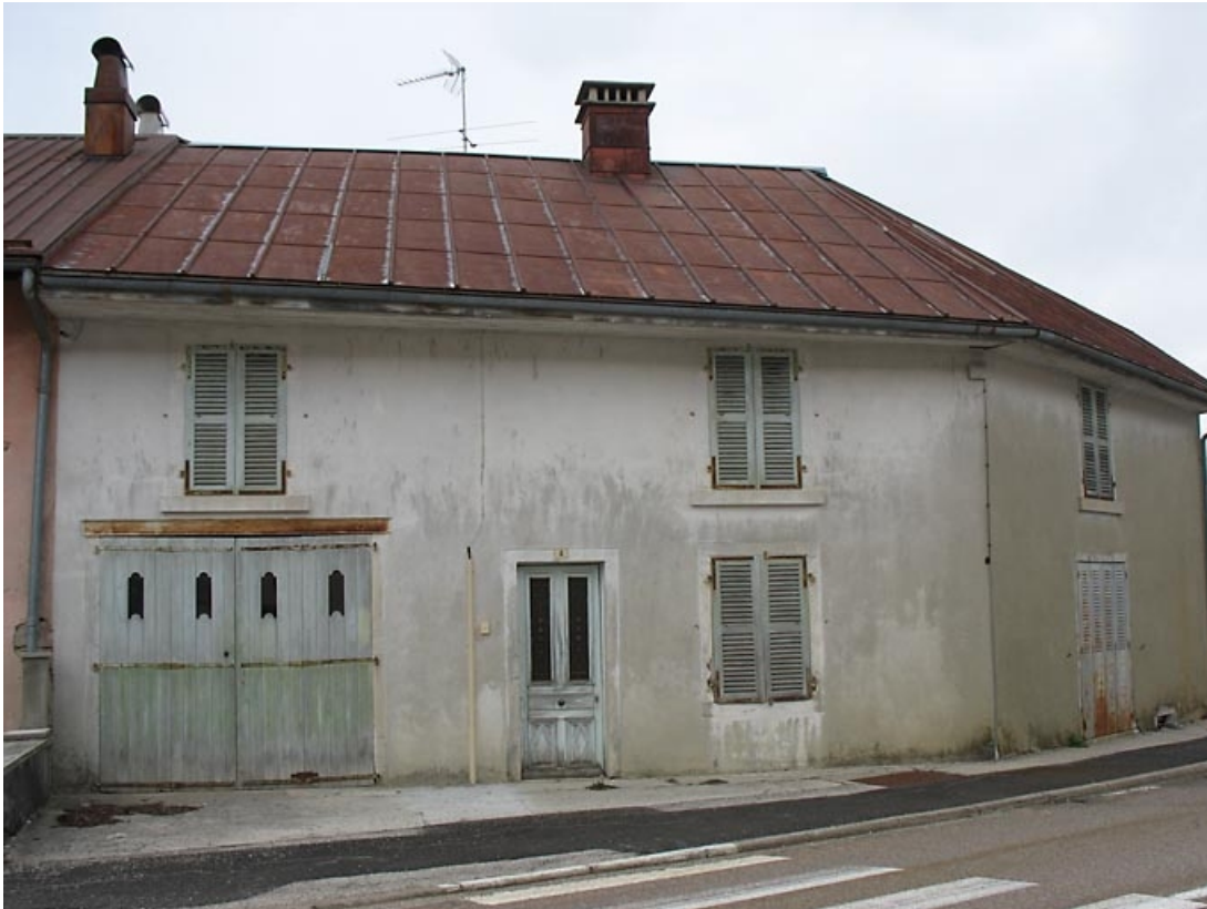
Vue générale de la façade antérieure.
