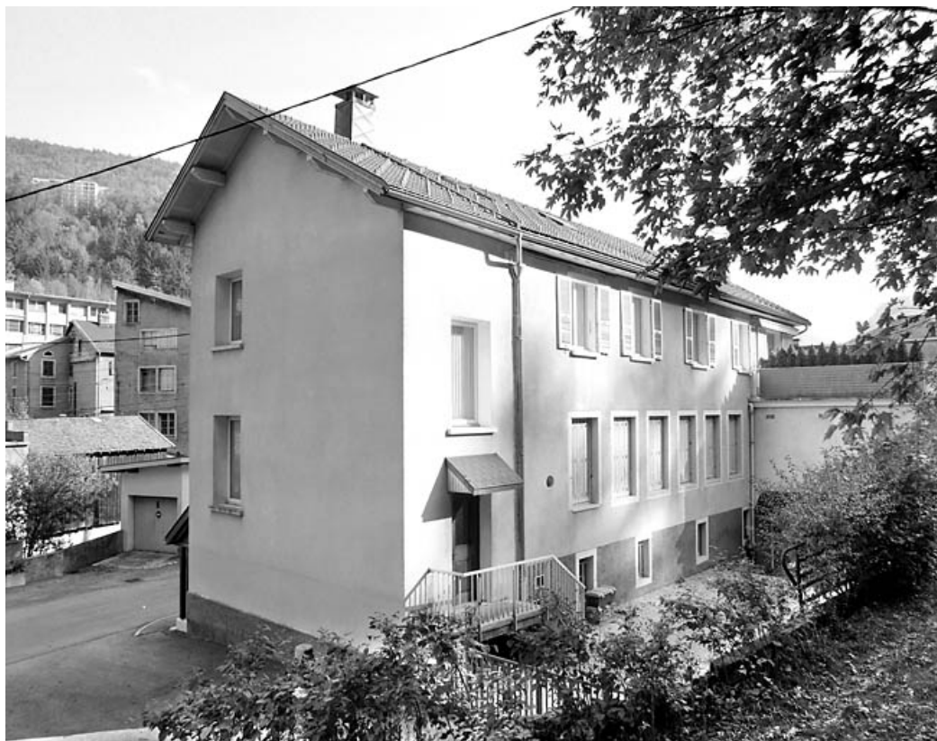
Elévation postérieure, de trois quarts gauche.
