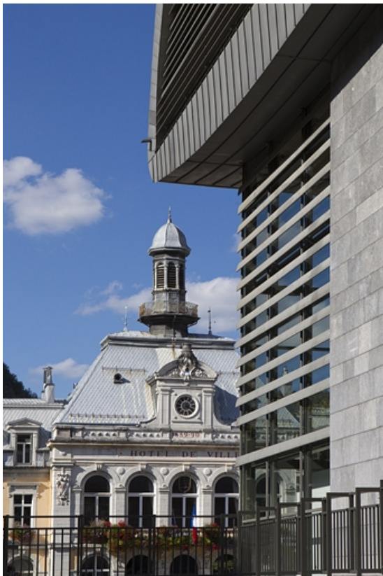
Façade latérale droite : détail.
