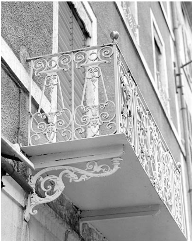
Balcon du premier étage : garde-corps et console.
