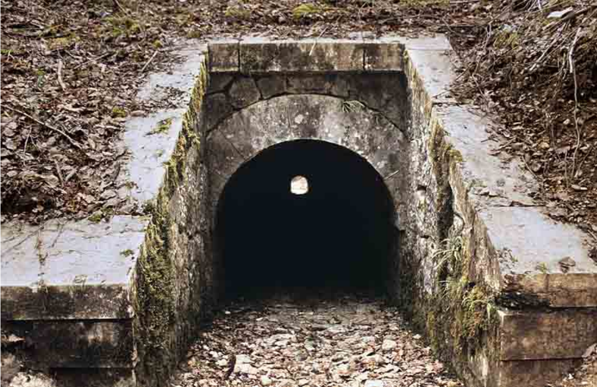
Aqueduc : tête amont (est).
