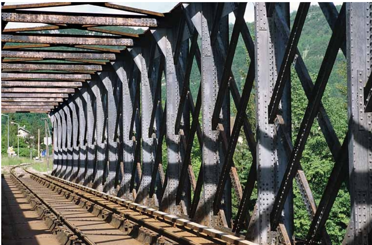
Paroi aval, depuis le tablier côté Andelot-en-Montagne.
