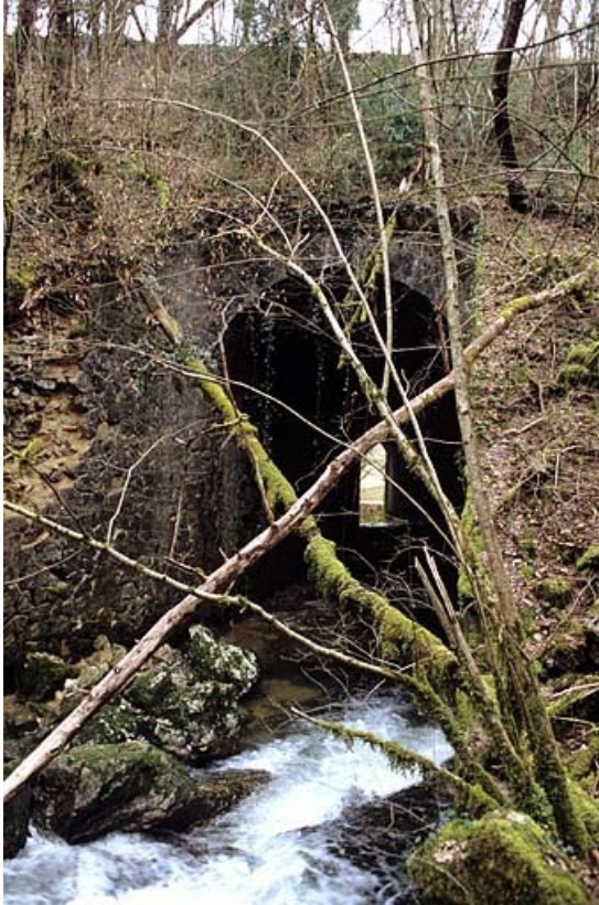
Pont sur le Lizon, depuis l'amont (nord).
