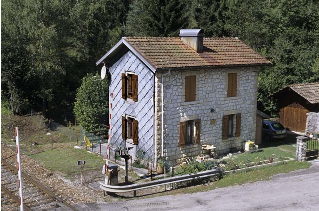
Façades antérieure et latérale gauche (côté voie).
