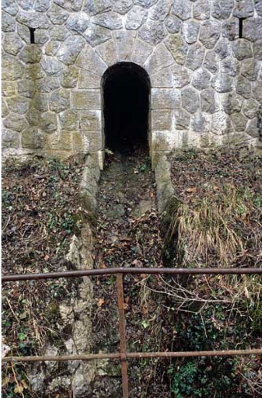
Aqueduc de 70 cm.
