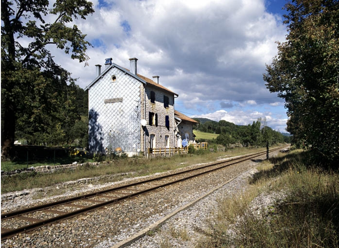
Vue d'ensemble, depuis le sud (façade postérieure).
