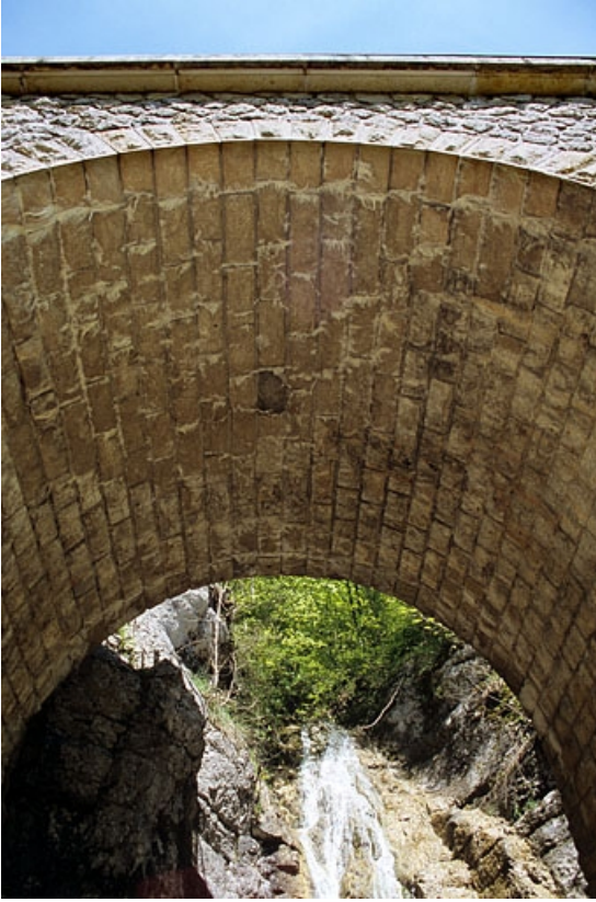
Viaduc : arche, vue du dessous.
