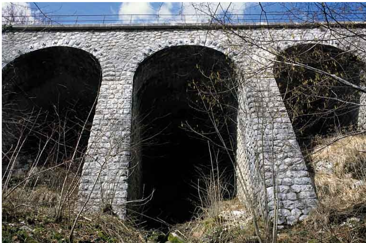
Mur de soutènement de la route : arcades.
