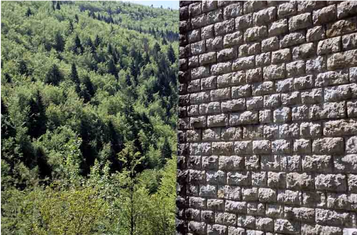
Viaduc du Puits : parement d'une pile.
