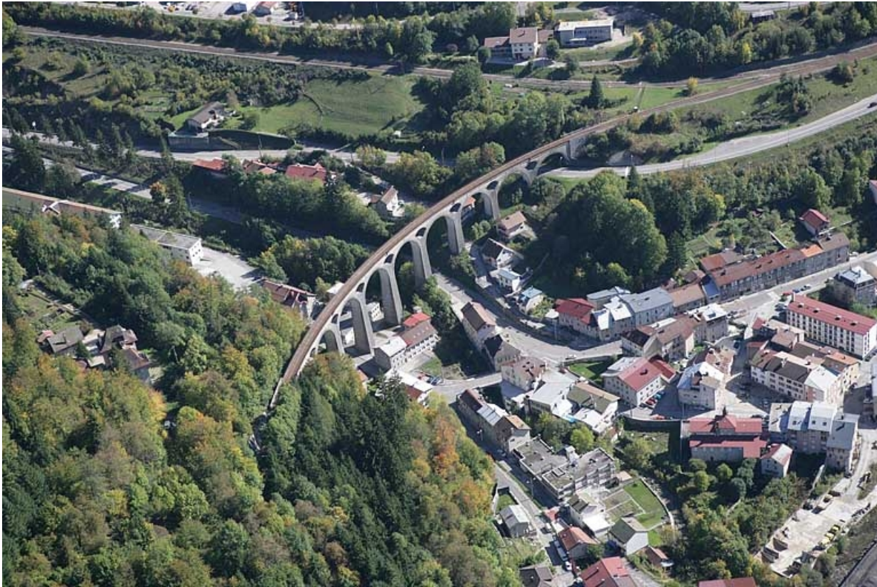
Vue aérienne rapprochée, depuis l'ouest.
