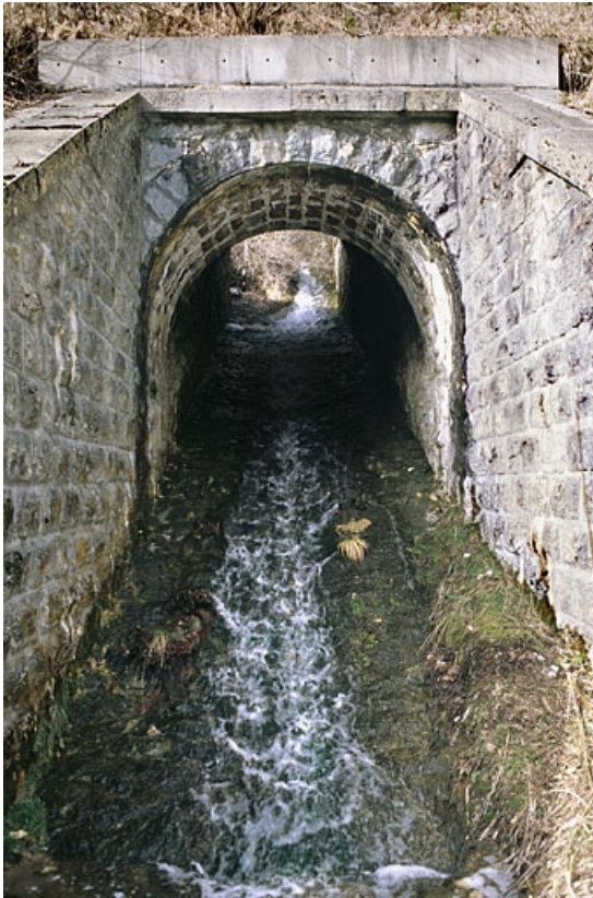
Pont : vue d'ensemble, depuis le sud (aval).
