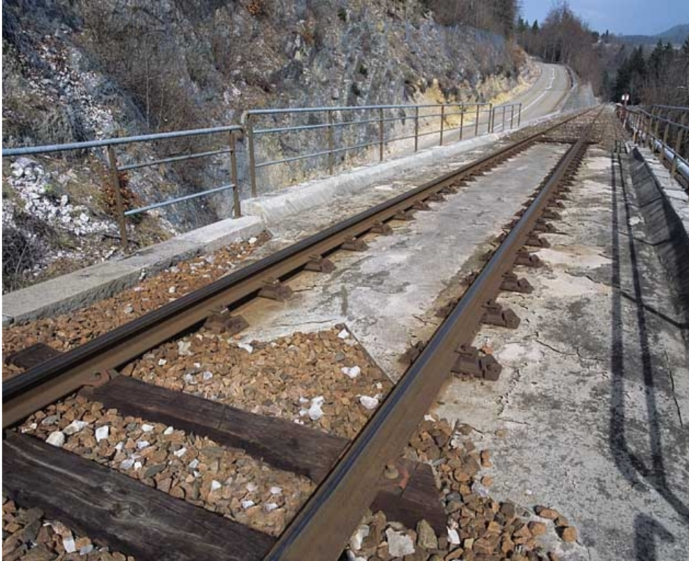
Système d'attaches directes sur le tablier.
