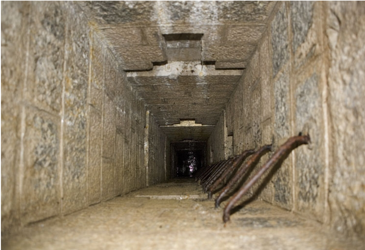
Chambres de mine sud-ouest : intérieur du puits.
