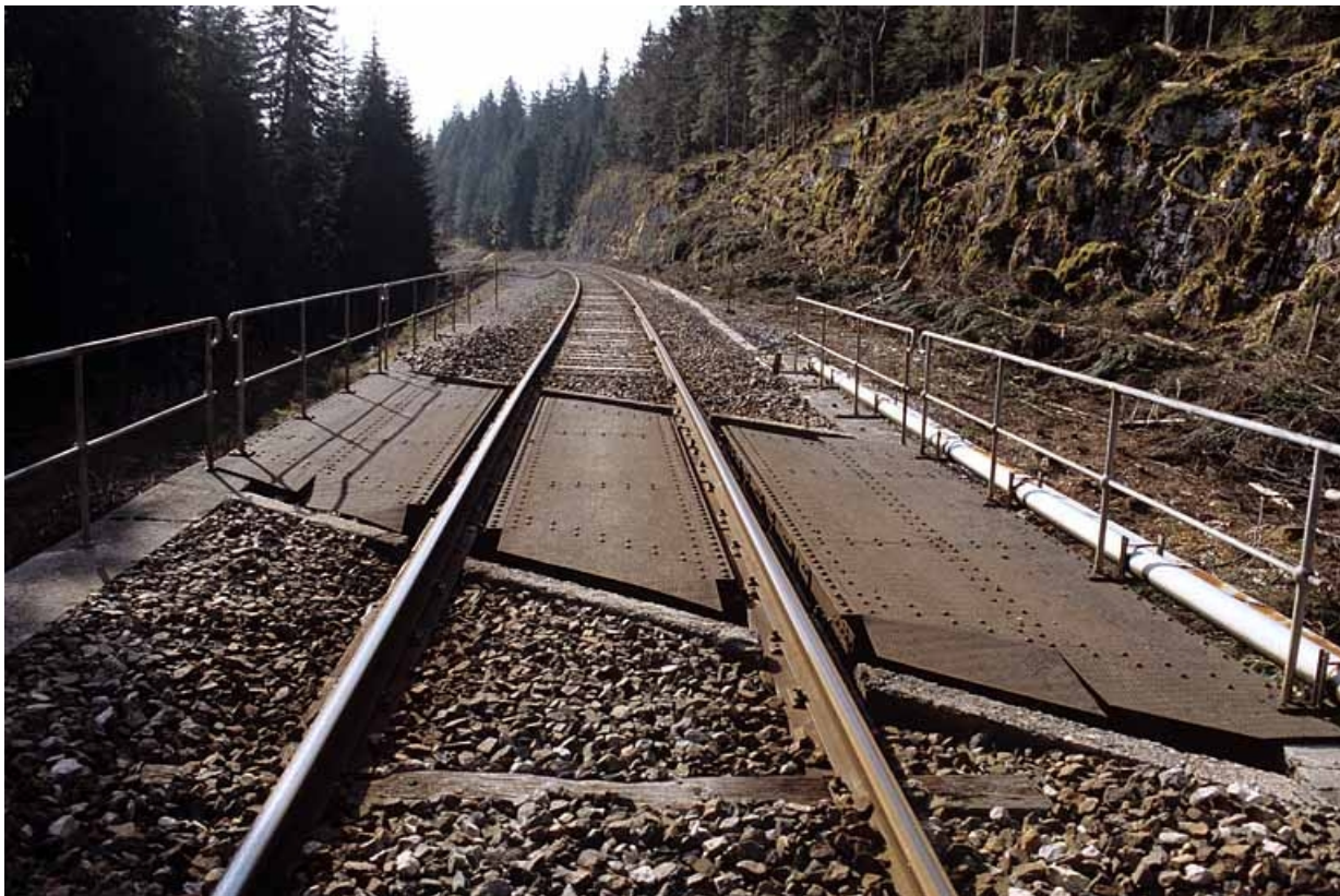
Tablier métallique, depuis la voie côté Andelot-en-Montagne.
