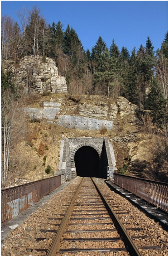
Tunnel : tête du côté La Cluse.
