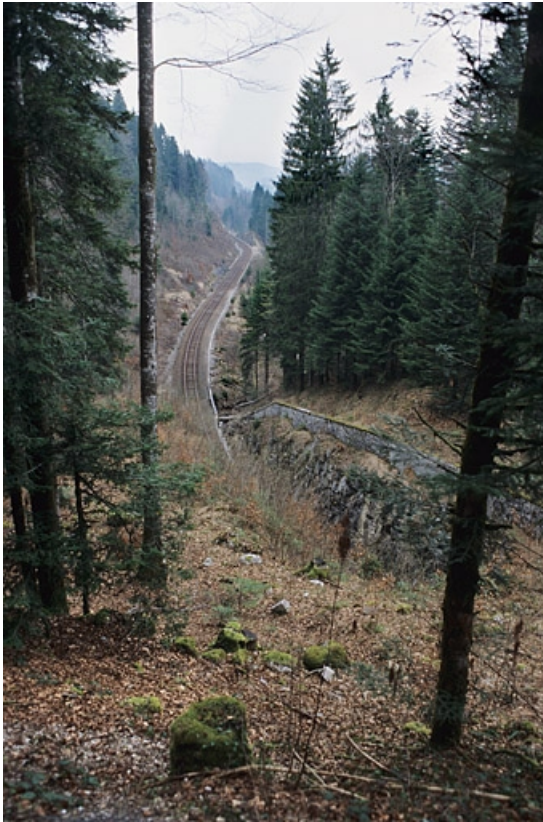
Tranchée et mur de protection côté Andelot-en-Montagne.
