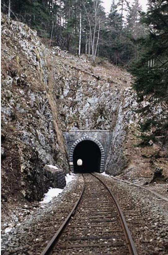
Tunnel : tête côté La Cluse.
