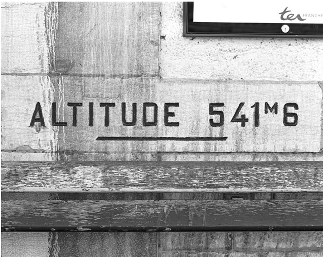
Bâtiment des voyageurs : inscription altimétrique.
