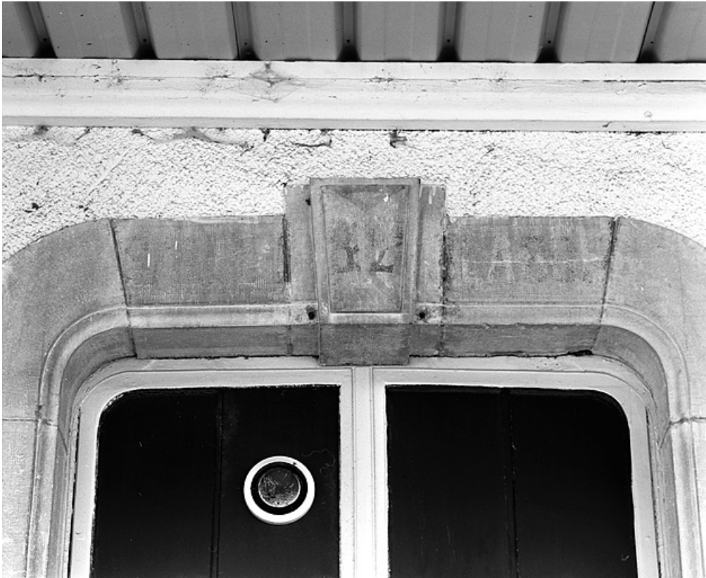
Bâtiment des voyageurs : plate-bande d'une fenêtre.
