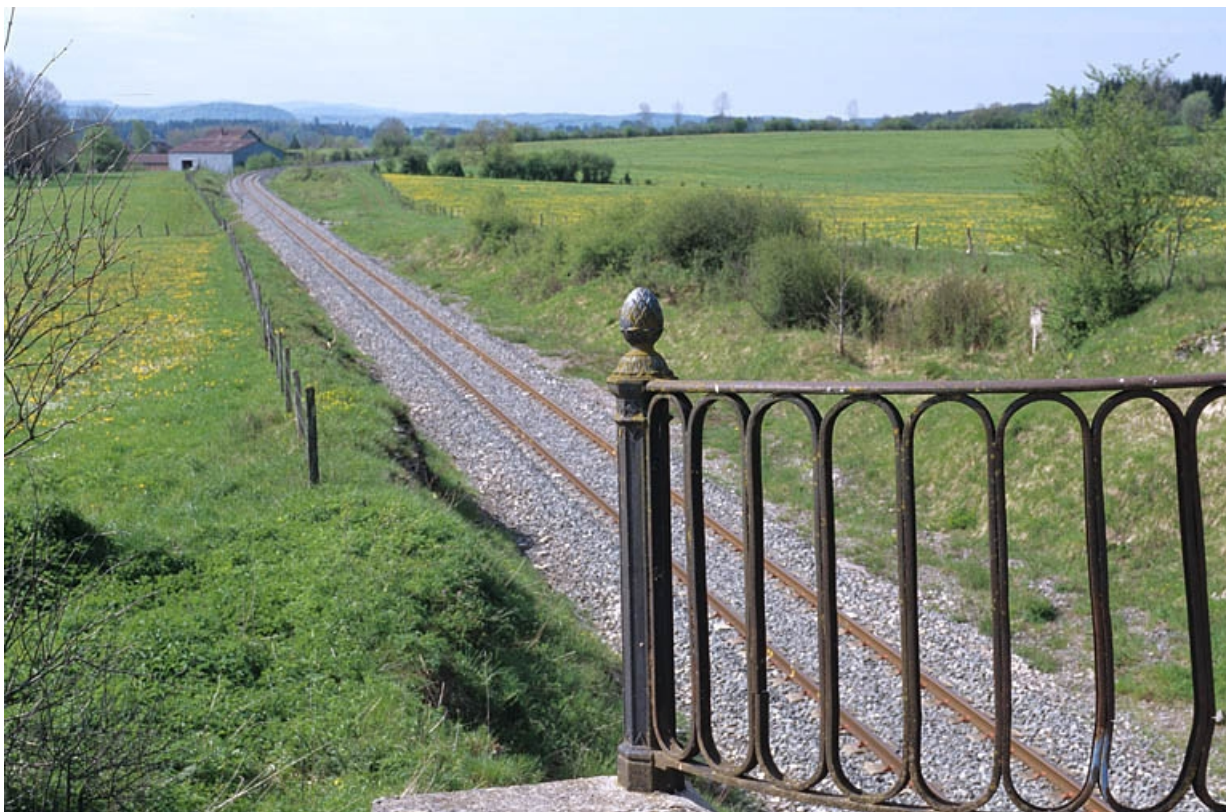
Potelet est du garde-corps sud.
