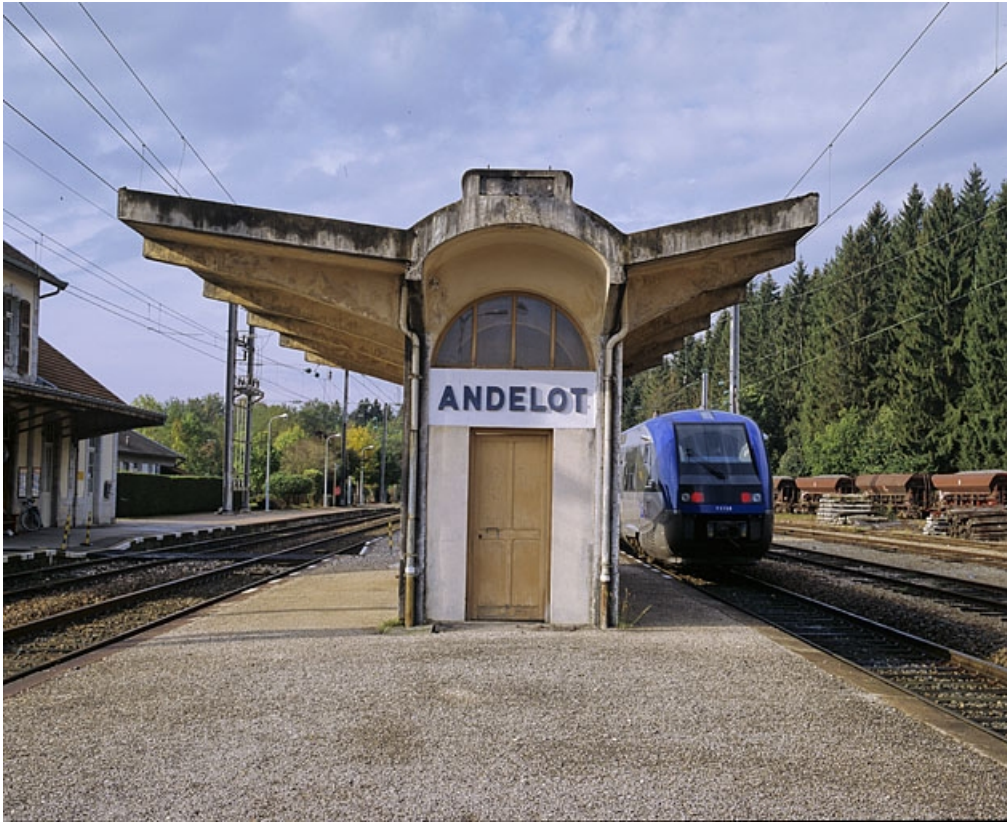
Abri de voyageurs, depuis le nord-est.
