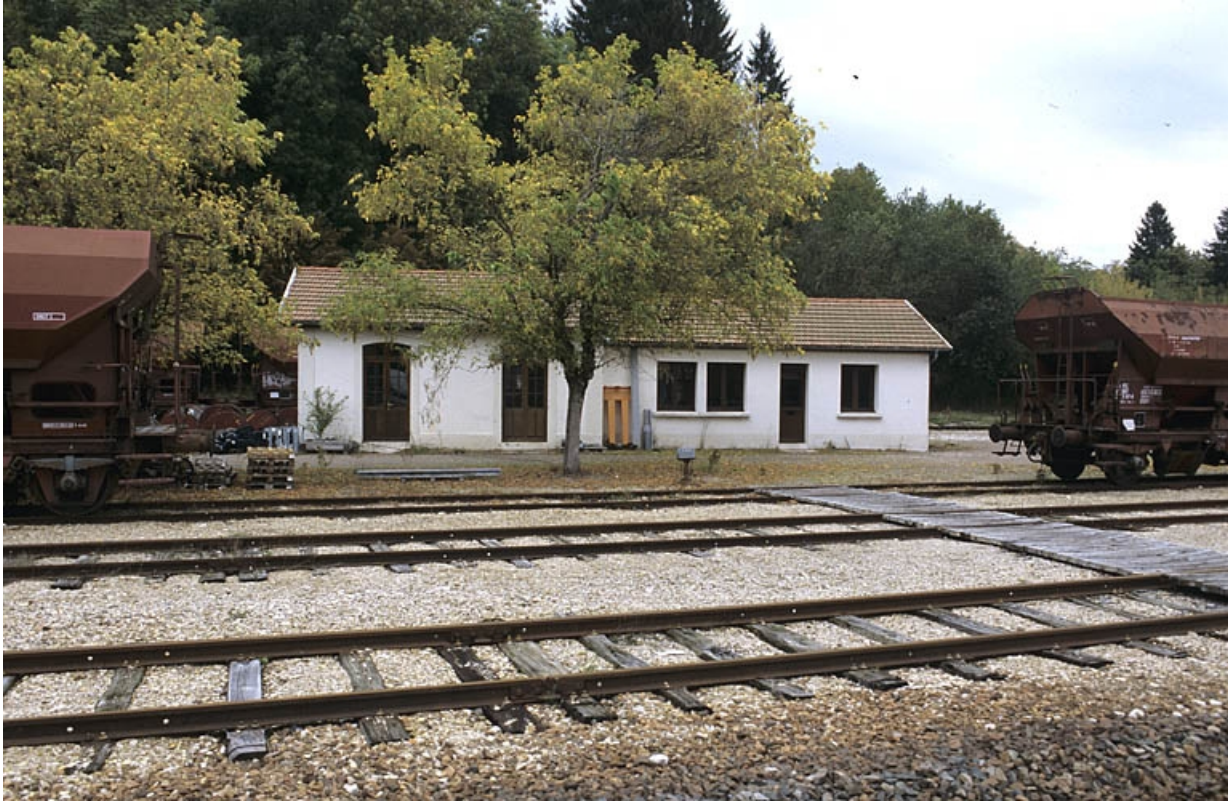
Ancienne lampisterie (bureau des électriciens), de face.
