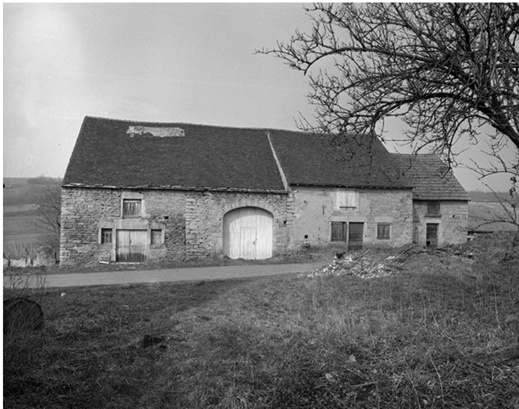
Façade antérieure, vue de face.
