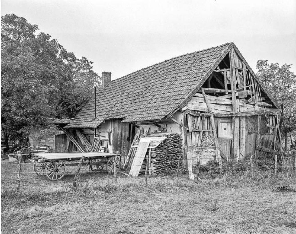
Façade antérieure et face droite.
