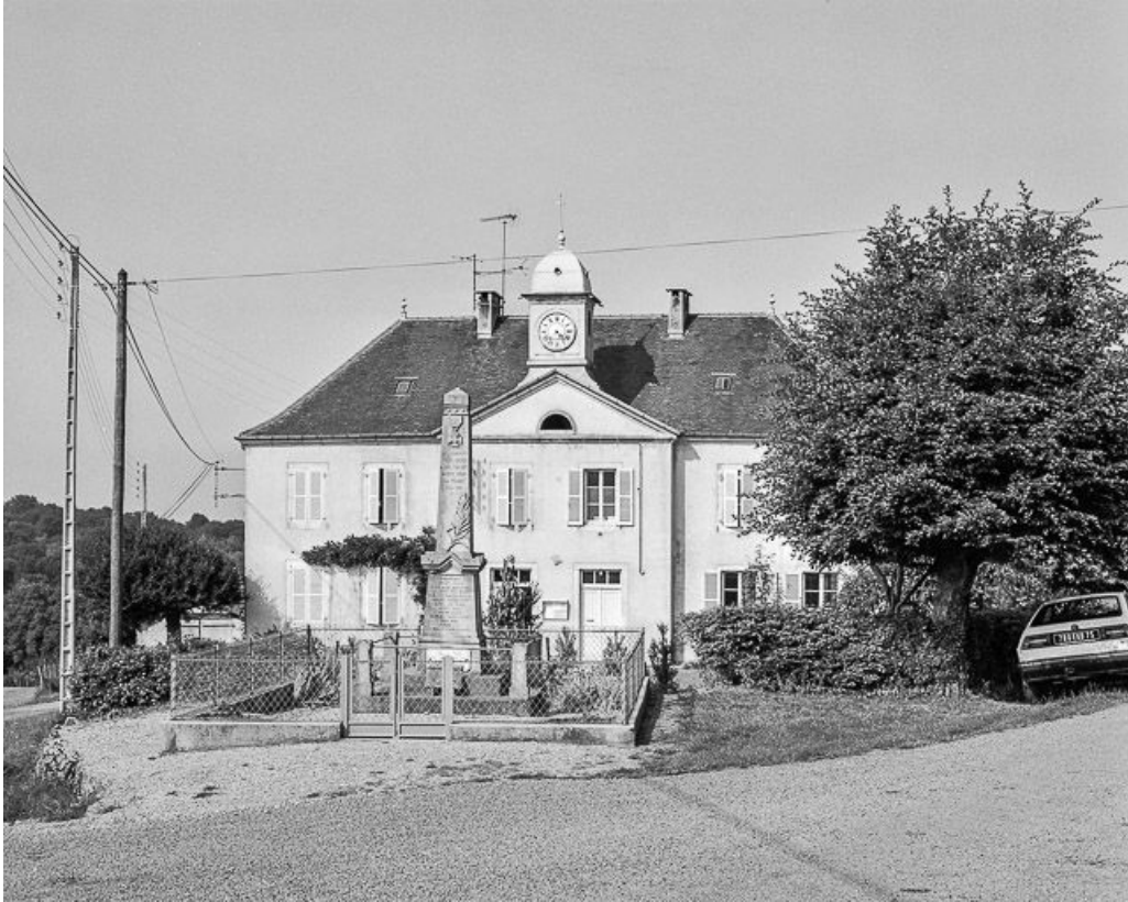
Façade antérieure vue de face.
