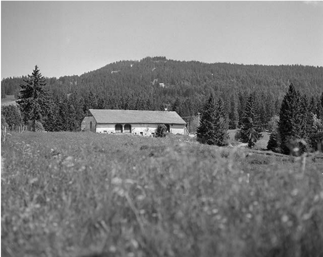
Vue éloignée de la façade postérieure.
