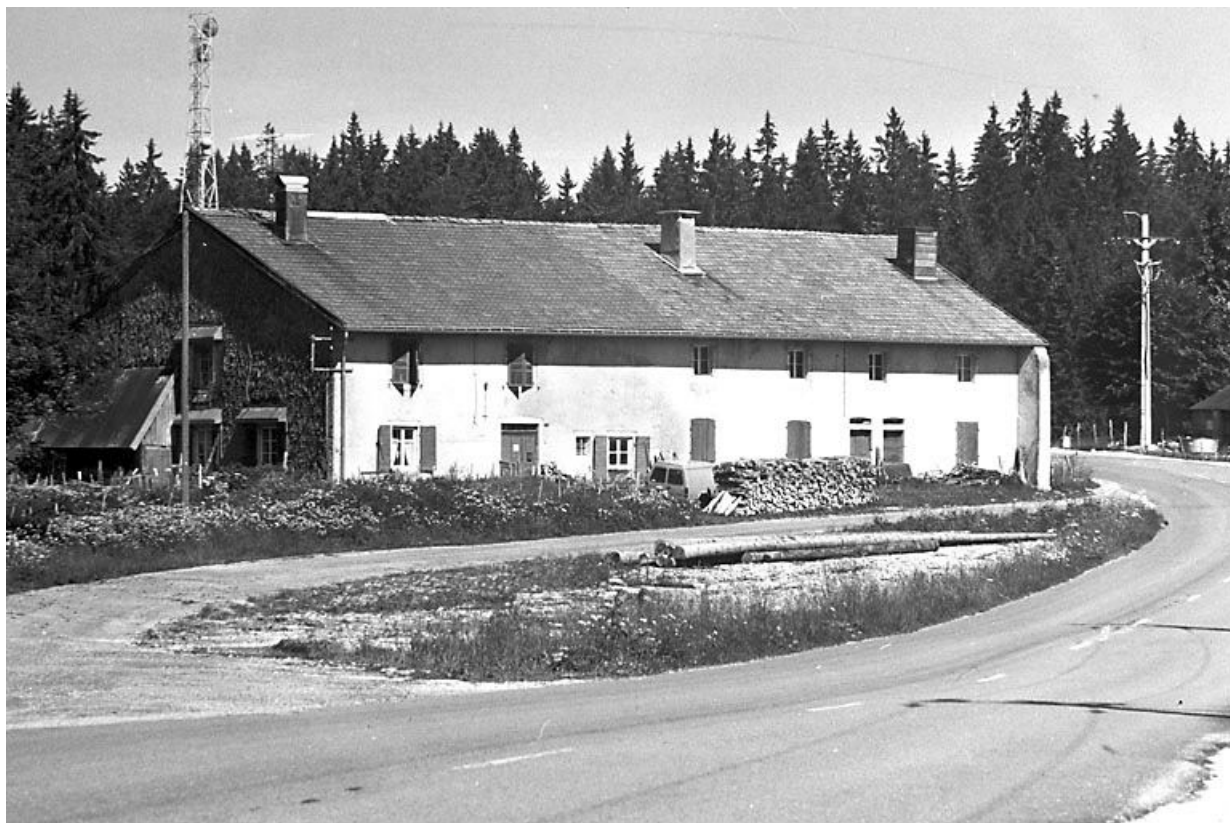
Vue éloignée de la façade antérieure.
