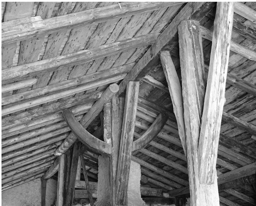
Charpente, colonne sous faitage et contrefiche.
