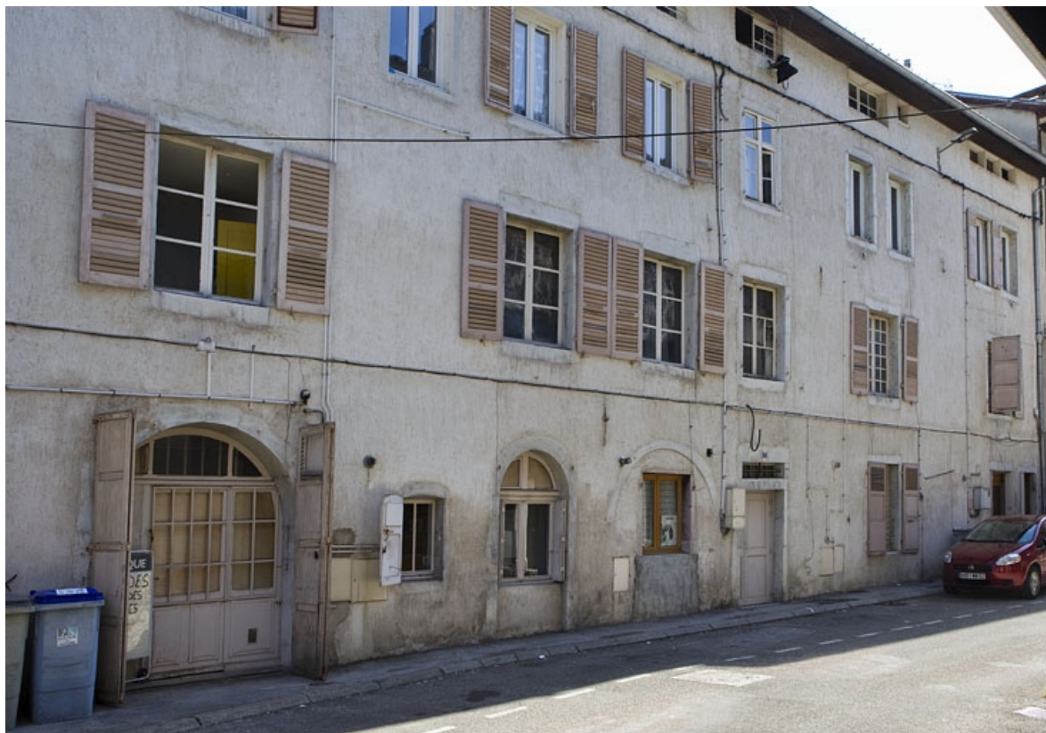
Elévation postérieure, rue des Promenades.
