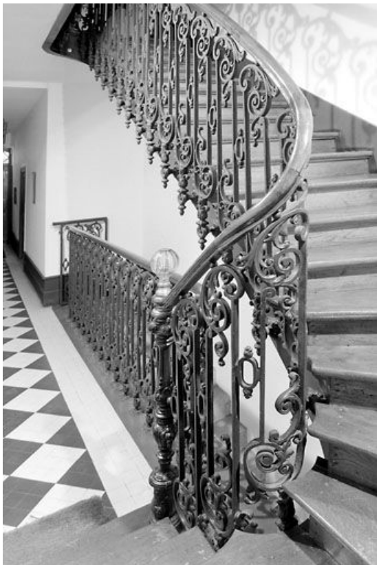
Escalier tournant, depuis l'extrémité du couloir.
