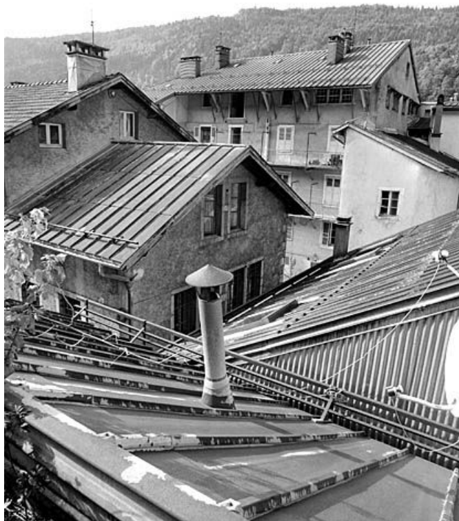
Toitures des bâtiments est et nord-est.
