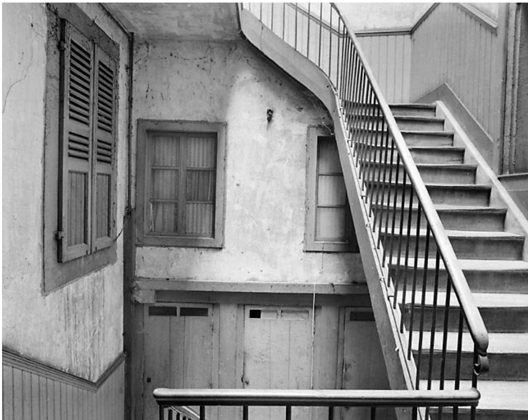
Cage d'escalier, au premier étage.
