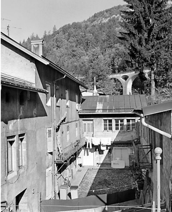
Façade postérieure, vue en enfilade.
