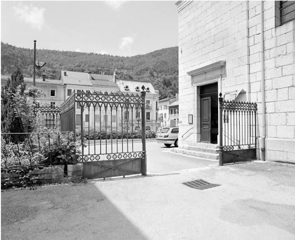
Grille à l'entrée de la cour.
