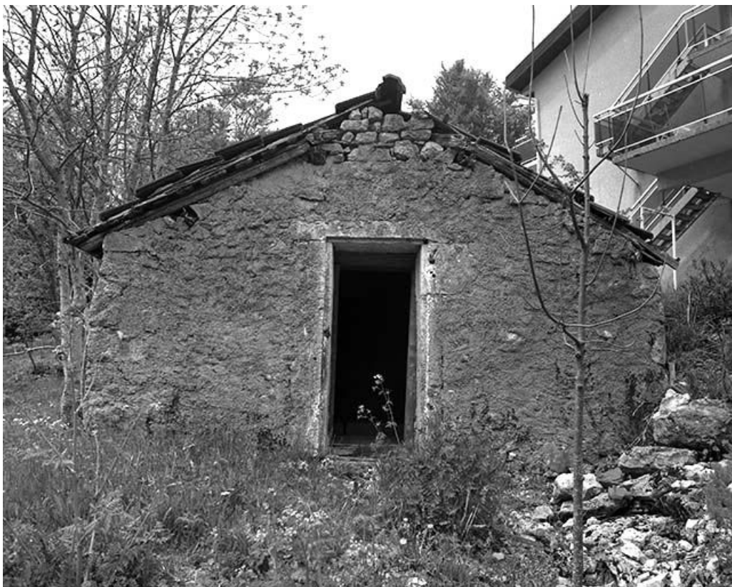
Façade antérieure de la resserre, " grenier fort ".
