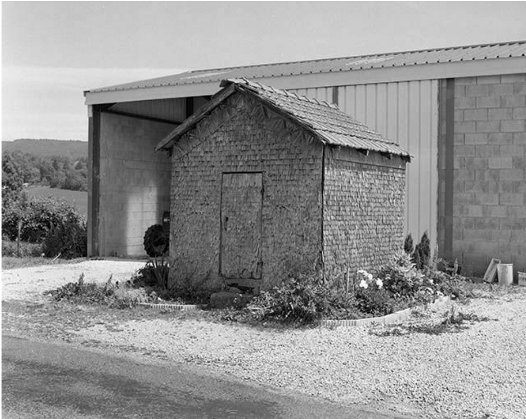
Resserre ou " grenier fort ".
